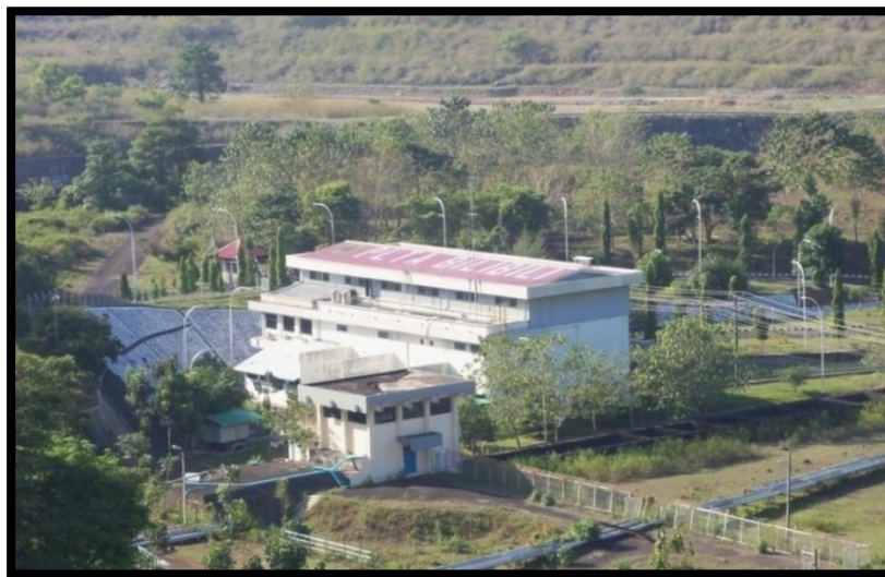
Gambar 2. 6 Gedung pusat pembangkit ( power house )
